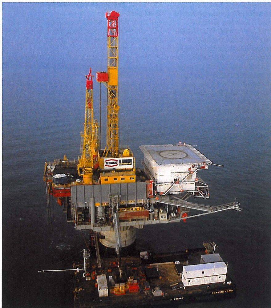
Das Off-shore-Erdölfeld Schwedeneck-See in der Kieler Bucht wird gegenwärtig durch das Konsortium Deutsche Texaco AG/Wintershall AG erschlossen. Im Herbst 1984 soll von der abgebildeten Förderplattform A das erste Öl zur Aufbereitungsanlage fließen.
