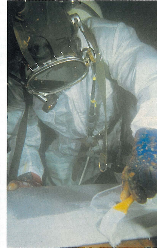
Auch unter Wasser lassen sich Anstriche auf Epoxidharzbasis zum Schutz gegen Korrosion auftragen. Als Spezialhärter dafür liefern wir ein Amin aus unserem ®Laromin-Sortiment.
