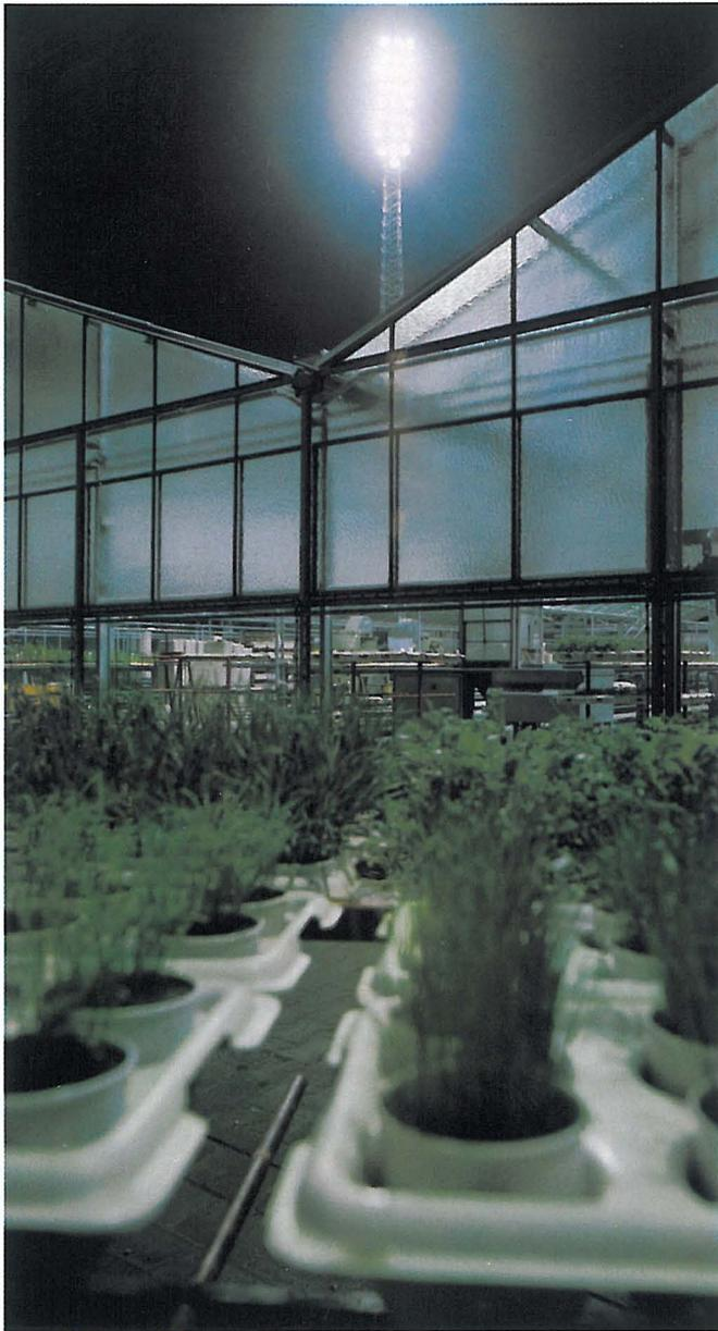
Flutlichtanlage in der BASF-Versuchsstation Limburgerhof. Sie ermöglicht, unabhängig von der Jahreszeit, die Lichtdauer in den Gewächshäusern unter weitgehend natürlichen Bedingungen beliebig zu variieren
