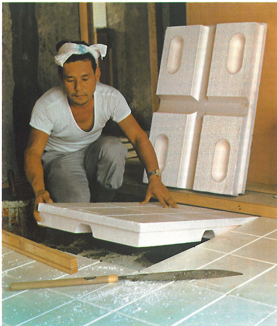
Verlegung von Schaumstoffplatten aus Styropor zur Fußbodenisolierung unter den traditionellen Tatami-Strohmatte in Japan.
