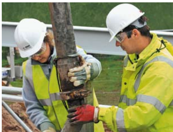
Claire Farrar auf der Baustelle des Niedrigenergiehauses in Nottingham, das im Frühjahr 2008 eingeweiht wurde.
