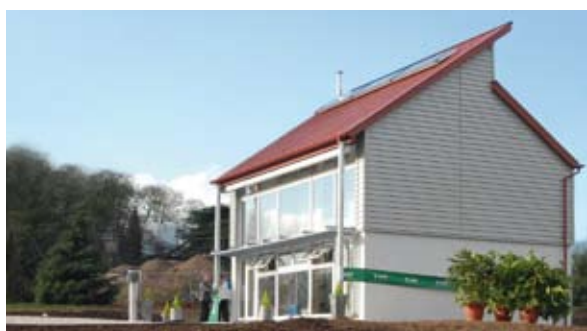
Der Einsatz innovativer Produkte spart Energie und schont Baumaterial: das BASF-Niedrigenergiehaus in Nottingham.
