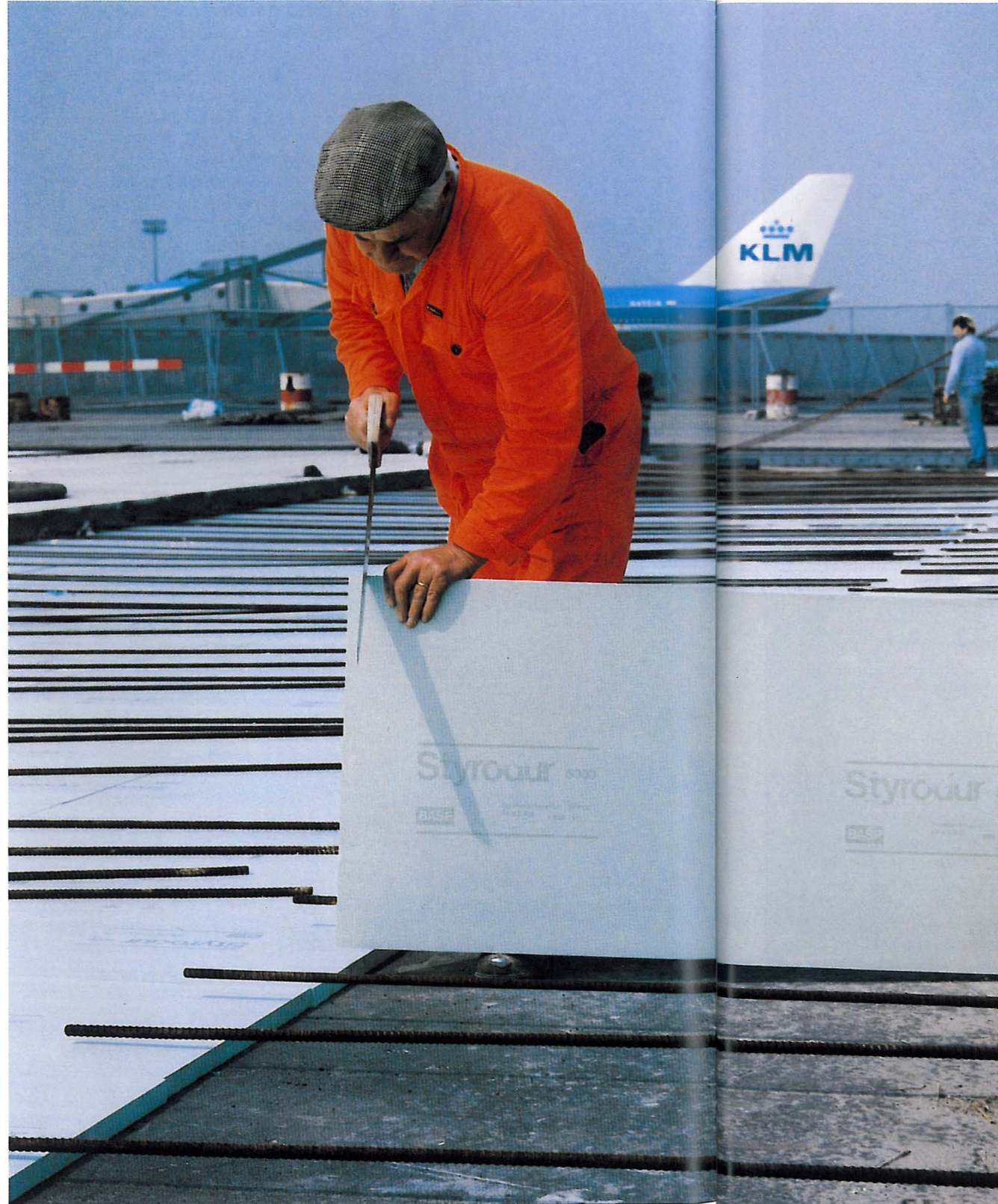
Unter ein Rollfeld des Flughafens Schiphol bei Amsterdam wurden Platten aus unserem Schaumstoff Styrodur® verlegt. Sie dienen als elastisches Bett zur spannungsfreien Lagerung der Beton-Fahrbahnplatten.
