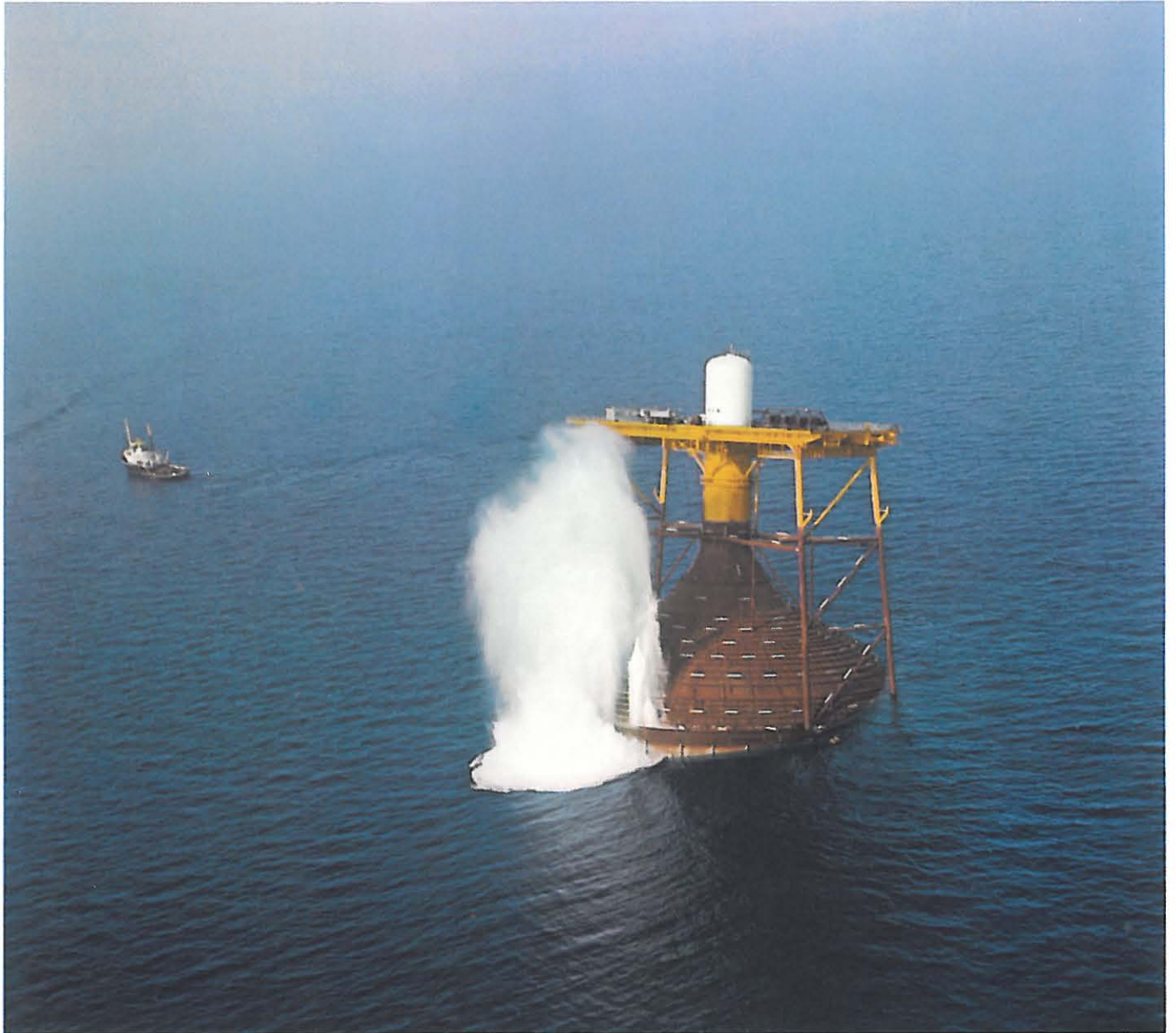
Versenken eines Erdölsammeltanks an der Küste des Persischen Golfs. Drei untereinander verbundene Tanks dieser Art bilden eine Anlage zur Beladung von Tankschiffen
