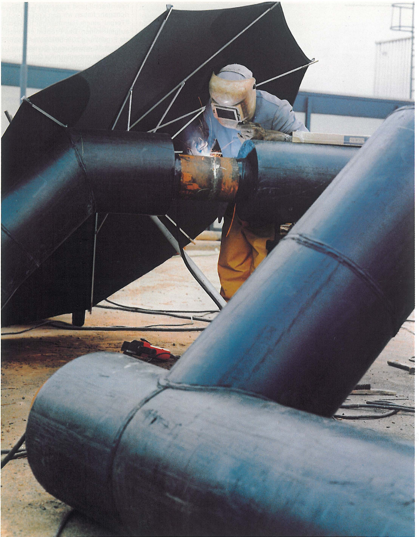
Diese Leitungsrohre für den Transport von Fernwärme, Flüssiggas oder Öl sind mit Lupolen ummantelt. Der Zwischenraum ist mit dem Hartschaum®Elastopor ausgeschäumt. Die Rohre in Längen von 6 bis 12 Meter werden beim Verlegen an Ort und Stelle verschweißt.
