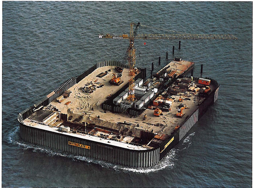
Das Konsortium Deutsche Texaco AG/Wintershall hat 1985 im Wattenmeer vor der schleswig-holsteinischen Küste mit einem Pilotprojekt begonnen. Es soll Aufschluß darüber geben, ob das Ölvorkommen Mittelplate, etwa 75 Millionen Tonnen Rohöl, wirtschaftlich genutzt werden kann. Die technischen Einrichtungen werden auf einer künstlichen Insel untergebracht, die im Wattenmeer aufgespült wurde. Umweltschutz und Sicherheit spielen dabei eine maßgebliche Rolle.
