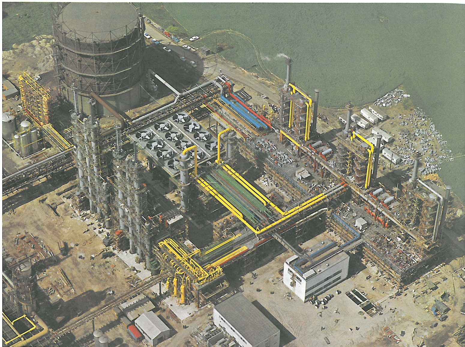
Die neue Acetylenanlage im Werk Ludwigshafen
