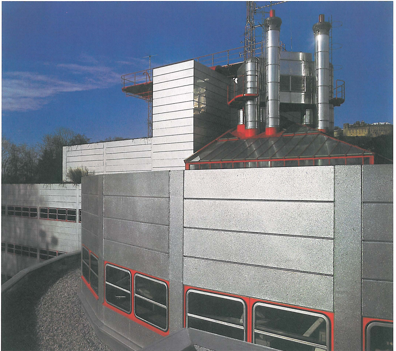
Landesstudio Salzburg des österreichischen Rundfunks. Die Betonfassaden wurden mit Herbol-Metallic-Dispersion gespritzt, der ersten lösungsmittelfreien Kunststoffdispersion mit metallischem Effekt
