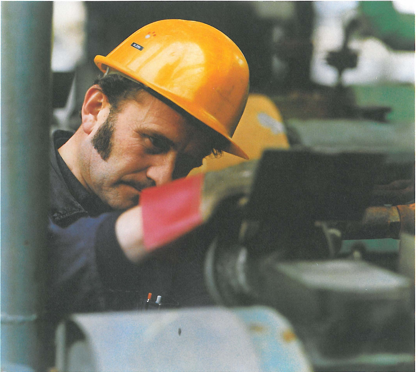
In der Ammoniak-Anlage im Werk Ludwigshafen
