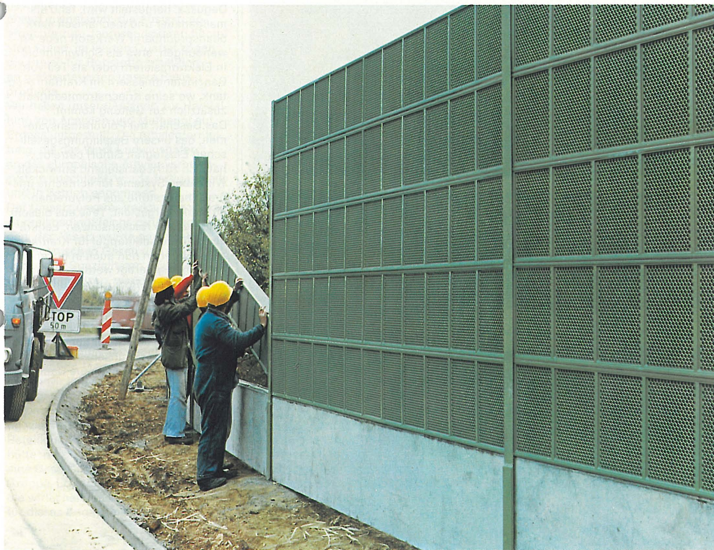
Wetterfeste Lärmschutzwand aus Vinoflex an einer Bundesautobahn. Das geringe Gewicht der vorgefertigten Einzelteile ermöglicht eine schnelle und kostengünstige Montage.
