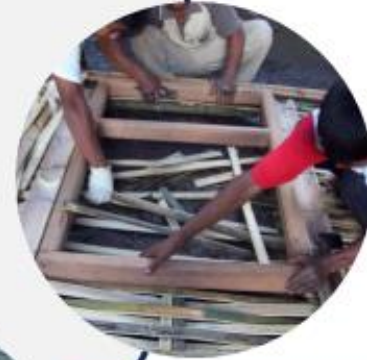
5. Pemasangan frame jendela/pintu
