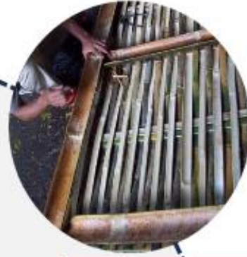
4. Pemasangan balok penjepit pada panel
