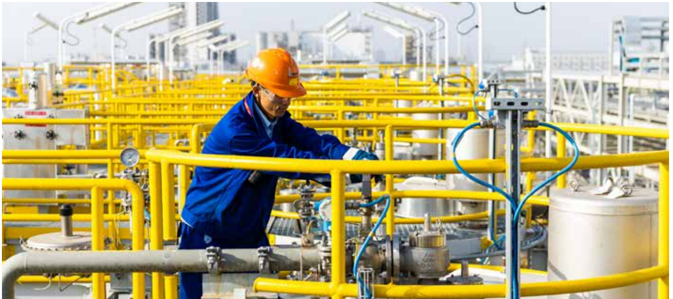
一名操作员在漕泾基地进行例行检查。
