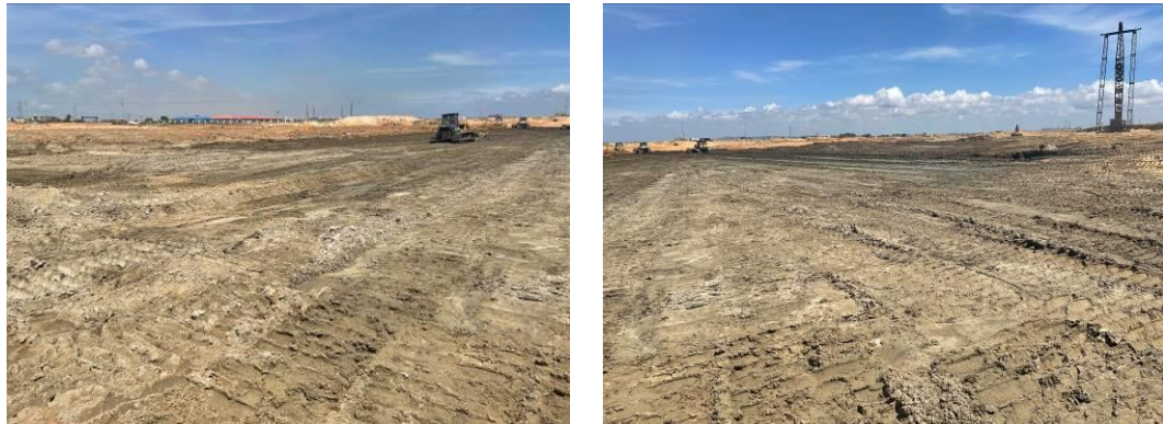
图 2-2 新建 220kV 总降站站址处现状
