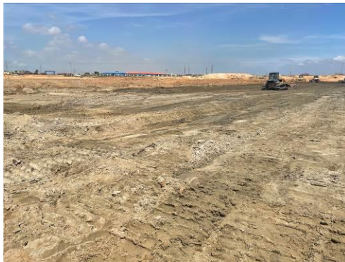
220kV 总降站站址处
