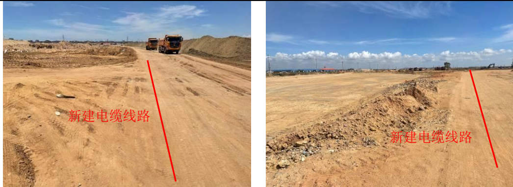
新建电缆线路沿线
