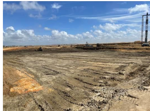
220kV 总降站站址处
