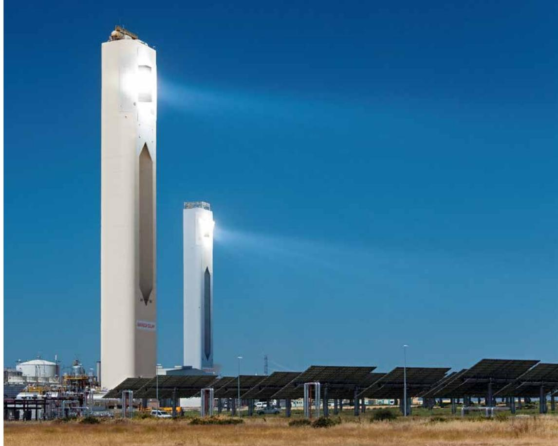
Solartürme erreichen den höchsten thermischen Wirkungsgrad. Das Kraftwerk PS20 des Unternehmens Abengoa Solar im spanischen Sevilla hat eine Leistung von 20 Megawatt.
