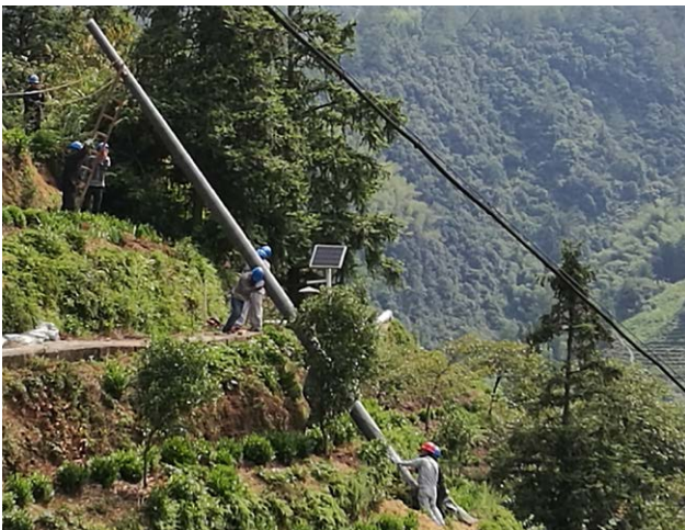
聚氨酯複合材料製成的電線桿確保山區的電力供應。
