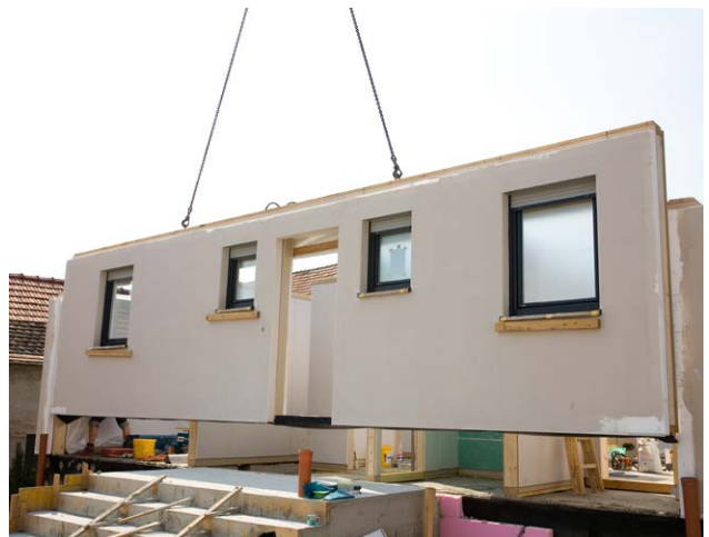
裝配式建築可提升現場施工效率，並能更好地管控建築部件的品質。
