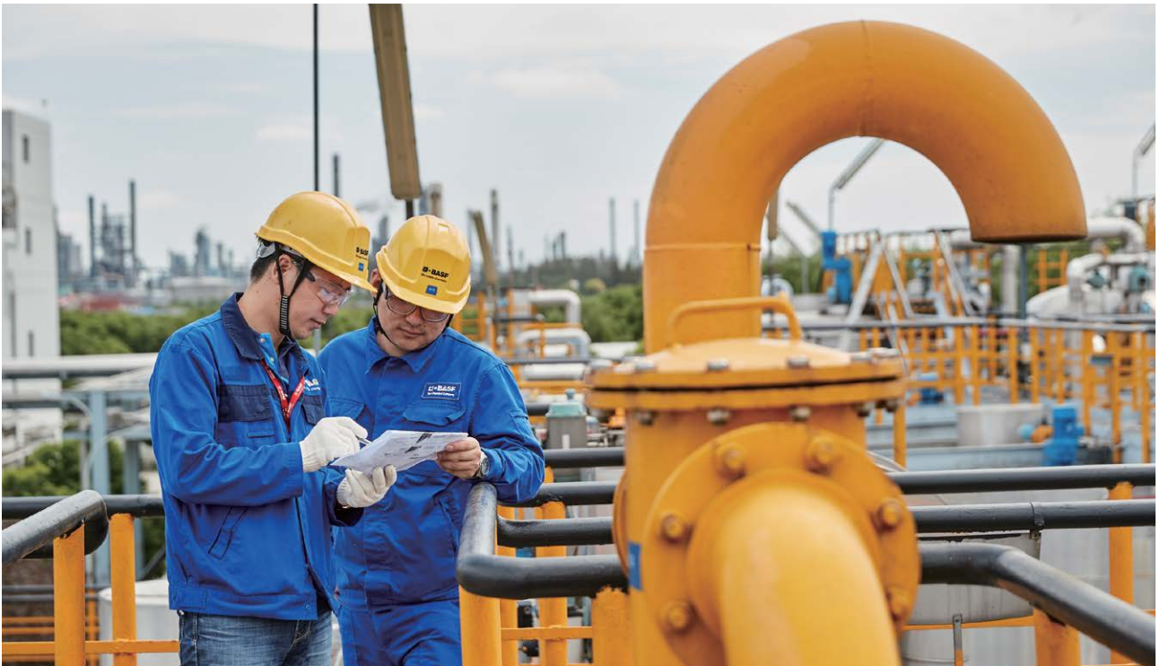
在巴斯夫聚氨基酯特性產品（中國）有限公司的罐區內，廢氣在裝置內處理後從排放點排出（黃色彎管）。
