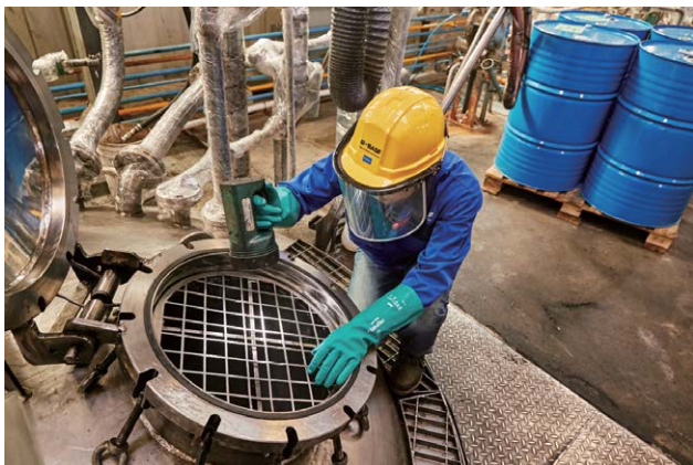
人孔保護網防止人員墜落傷害。
