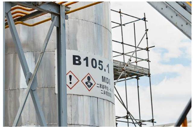
MDI儲罐上的安全標識
