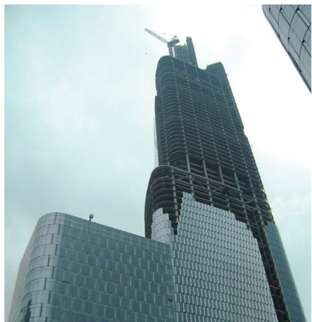
紫峰大厦共89层，高450米，打破了南京市的建筑高度记录，并成为全球第七高楼。
