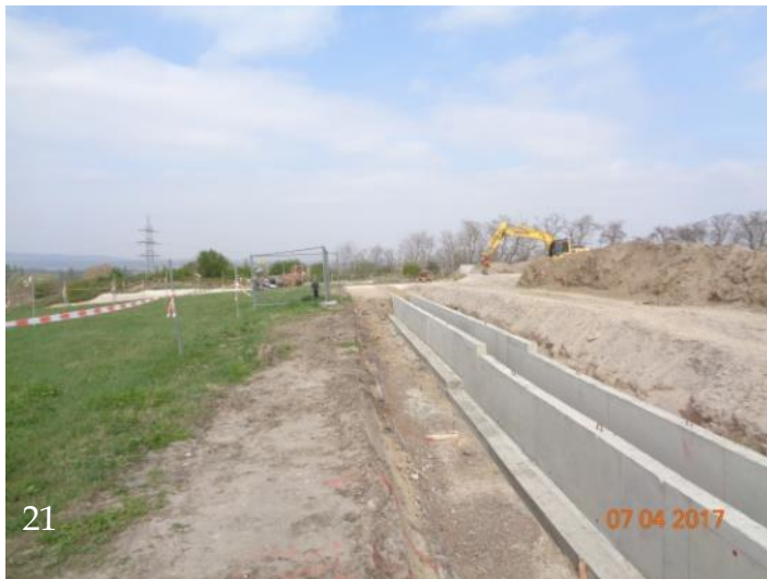
Betonierte Leitwand
