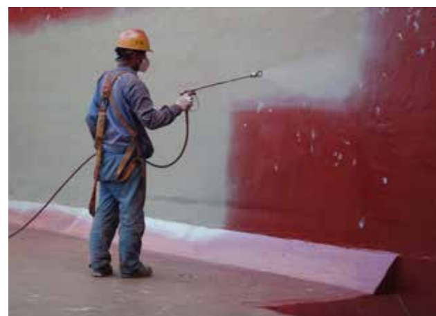
MasterSeal 7000 CR被应用于中法水务上海工厂的污水处理池中。
