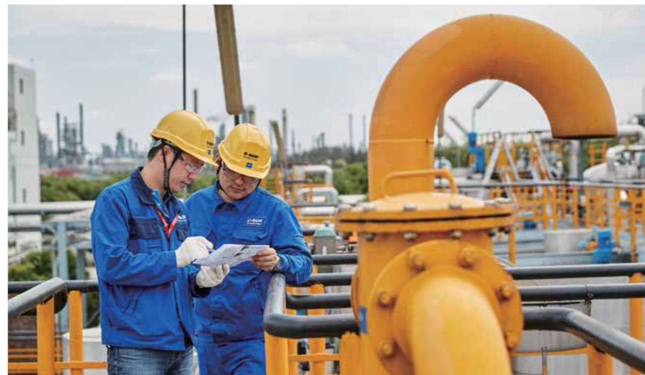
在巴斯夫聚氨酯特种产品（中国）有限公司的罐区内，生产废气在装置内处理后从排放点排出（黄色弯管）。
