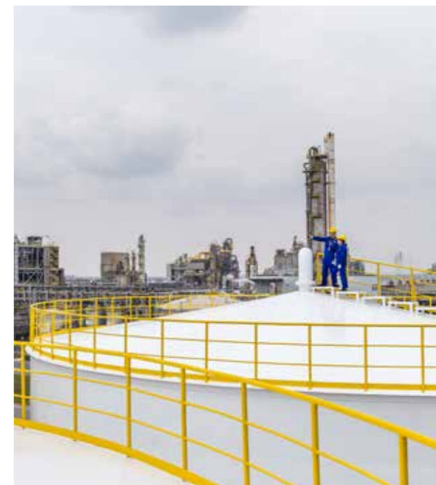
在上海漕泾基地，两位巡查员在对消防水罐进行常规检查，确保所有应急响应设施都处于最佳运行状态。
