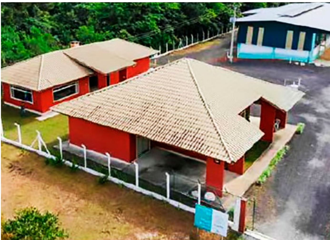
Central de recebimento do Sistema Campo Limpo em Contenda (PR), administrada pelo inpEV.
