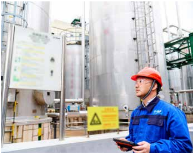
一名安全专员在位于浦东基地的助剂车间现场进行安全检查。
