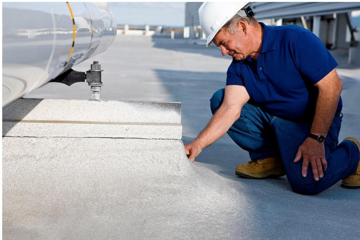
El aislamiento de los techos de los edificios nuevos y existentes es el principal campo de aplicación de la espuma de poliuretano en spray **Skytite®**.
