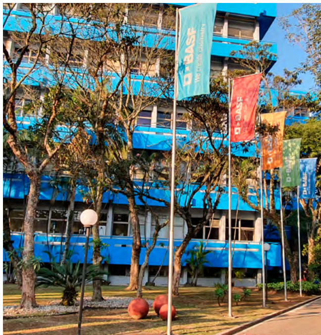
Complexo Industrial de Tintas e Vernizes da BASF em São Bernardo do Campo (SP, Brasil)
