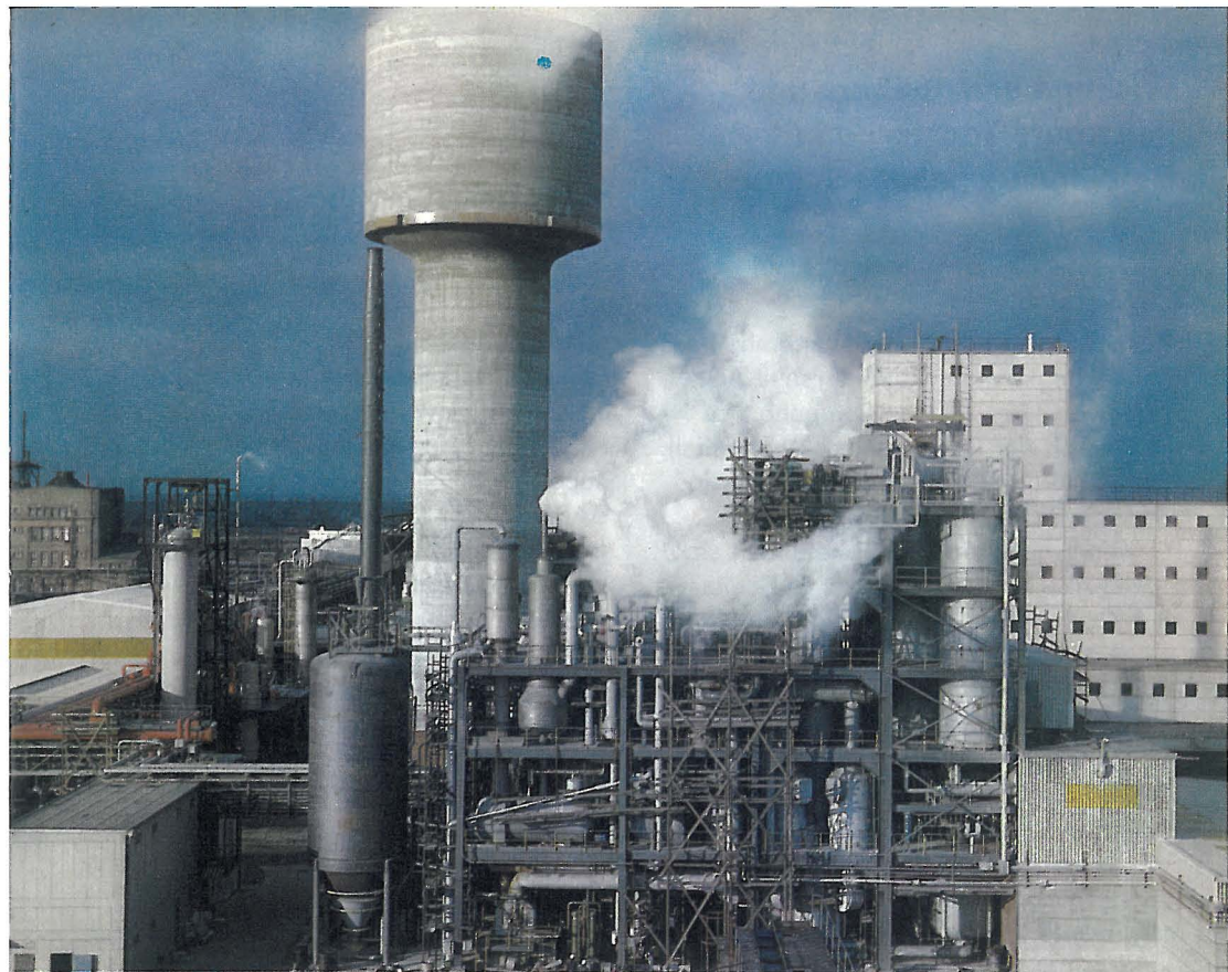
Neue Harnstoffanlage im Werk Ludwigshafen
