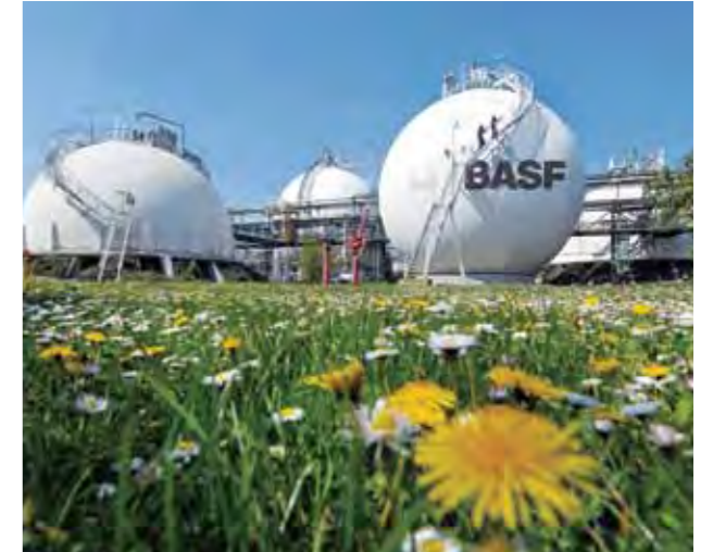
巴斯夫路德维希港一体化基地位于弗里森海姆岛的储罐设施。
