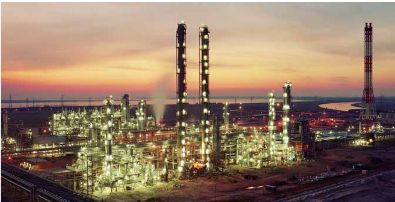
De stoomkraker 's nachts. Eén van de grootste en belangrijkste installaties op de site.
