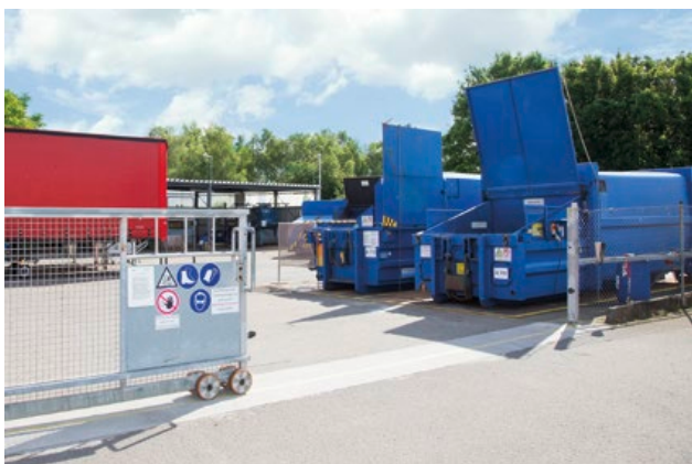
Das Abfallzwischenlager dient zur Sammlung der festen Abfälle
