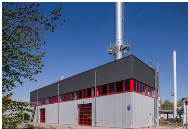
Strom und Dampf wird mittels einer Kraft-Wärme-Kopplungs-Anlage am Standort erzeugt
