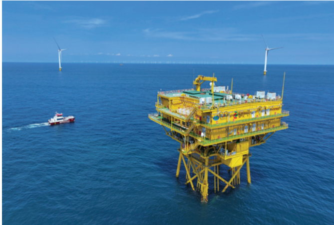
国家电投广东海上风电场将为巴斯夫湛江一体化基地供应可再生能源电力。
