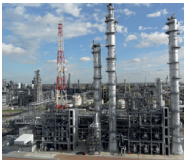
De butadiëeninstallatie is het opmerkelijkste investeringsproject van het afgelopen jaar.
