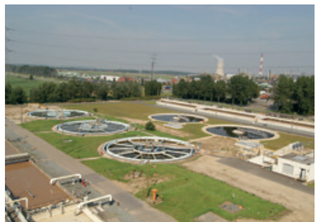
Onze waterzuiveringsinstallatie zuivert verontreinigd water.
