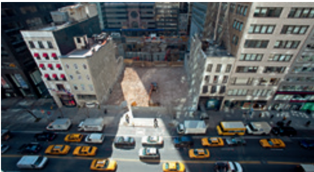
28 bij 28 meter: zo klein is de oppervlakte waarop 432 Park Avenue wordt gebouwd. Na voltooiing zal dit een van de hoogste woongebouwen ter wereld zijn.
